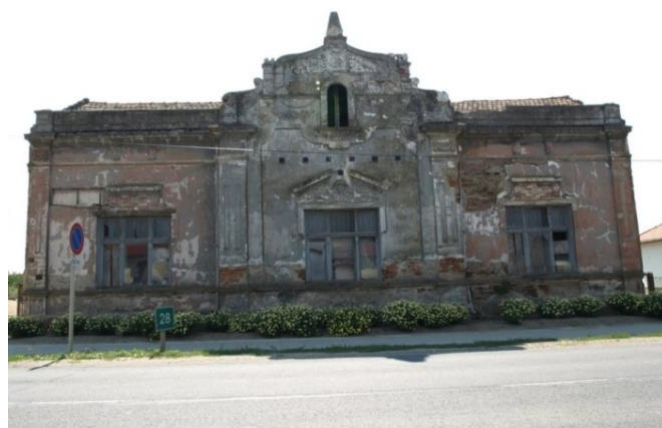
A Csizmadia- kúria utcai homlokzata
